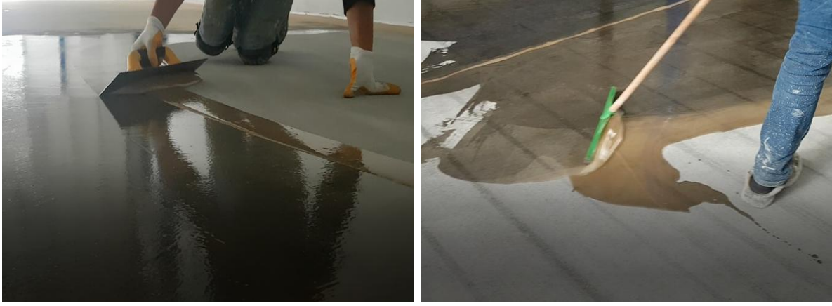
Yüzeyin epoksi astar ile astarlanması
