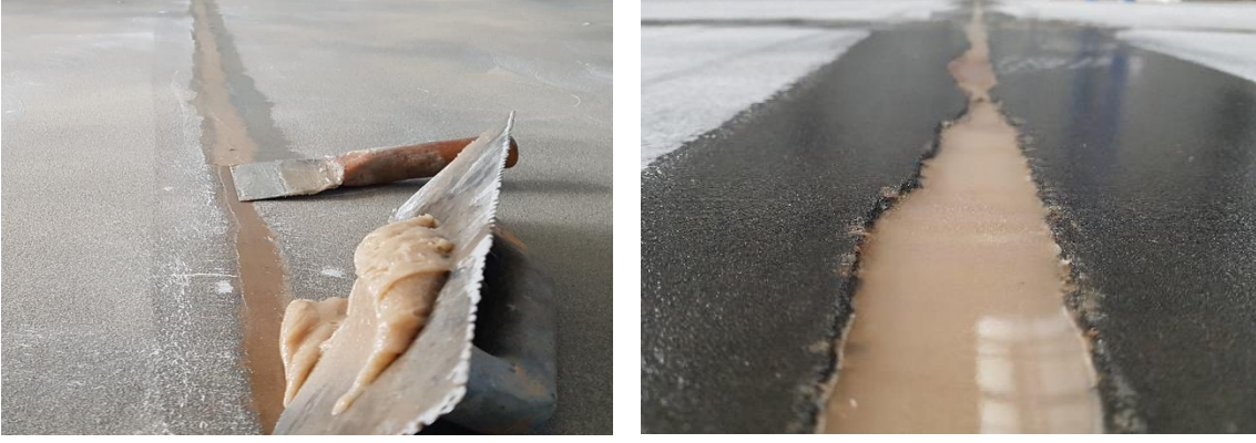
Çatlakların epoksi harç ile doldurulması
